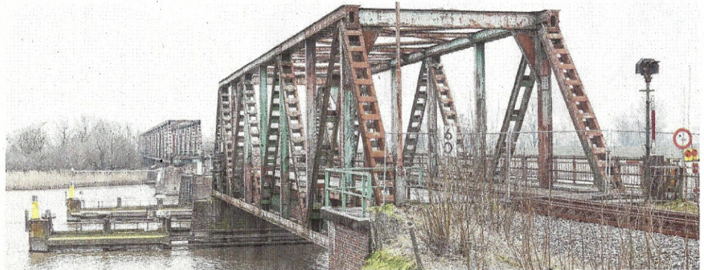
Ein Blick auf die bei einer Kollision zerstörte Friesenbrücke über die Ems:
