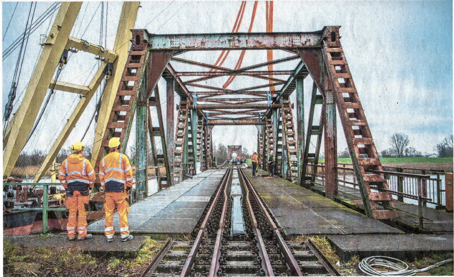
Arbeiter bereiten im Dezember den Abbau eines Teils der Friesenbrücke mit Hilfe eines Schwimmkrans vor. Etwa sechs Jahre nachdem ein Frachter die Friesenbrücke über die Ems bei Weener zerstörte, haben die Vorarbeiten für ein neues Brückenbauwerk begonnen. Foto: DPA
