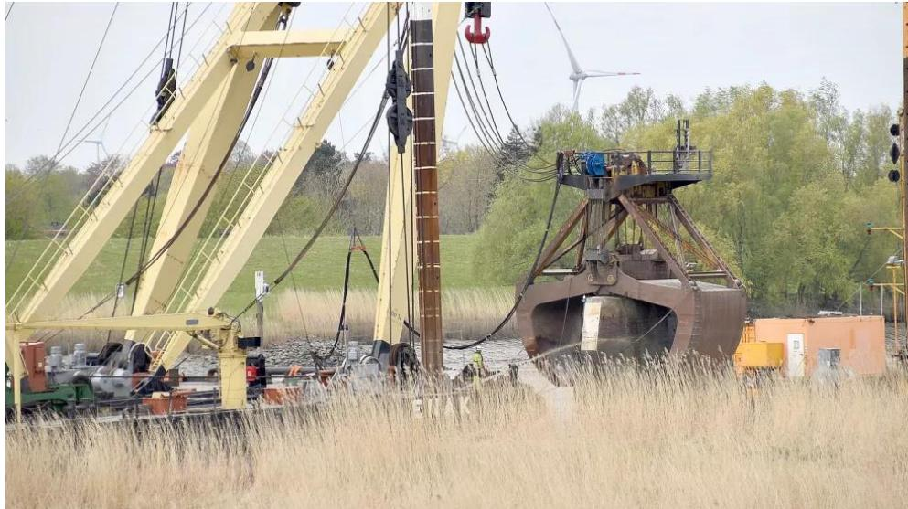
Aktuell wird der letzte im Fluss befindliche Pfeiler der alten Friesenbrücke mit Hilfe des Schwerlastkrans „Enak“ abgerissen. Foto: Ammermann
