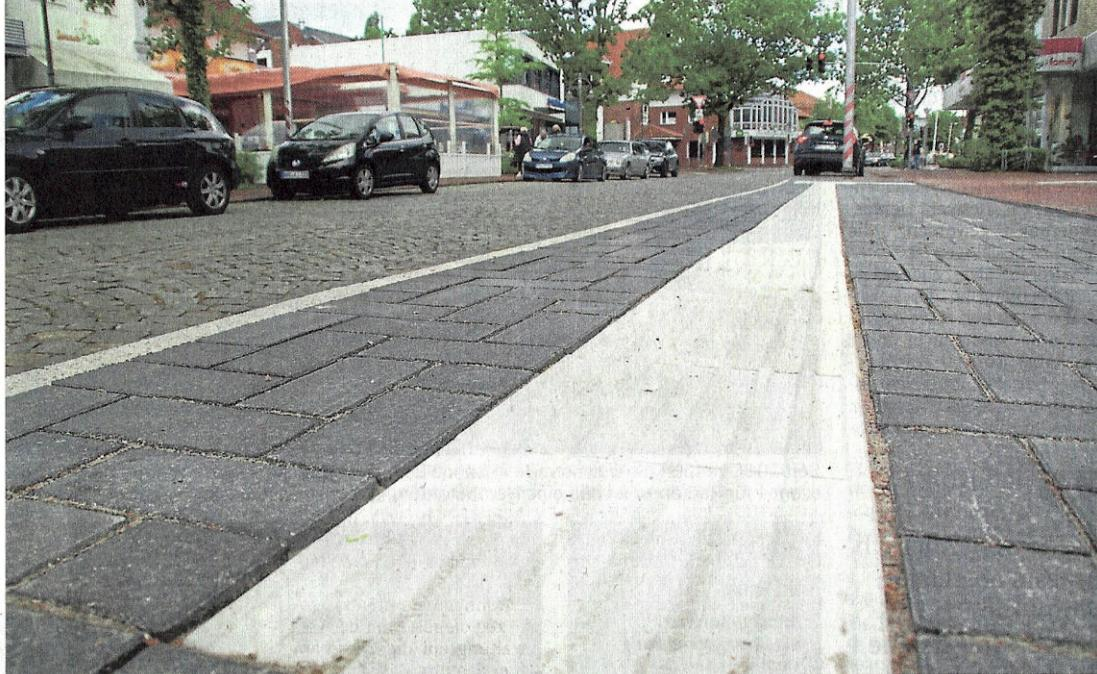
**Oben:** An der Menkestraße, schräg gegenüber vom Popken-Gelände, ist eine neue barrierefreie Bushaltestelle angelegt worden. Weiße Steine mit Rippenmuster ermöglichen Sehbehinderten die Orientierung per Blindenstock.
